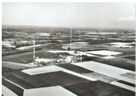
Photo de la station en 1969. On observe l'absence d'autres constructions dans ses alentours
