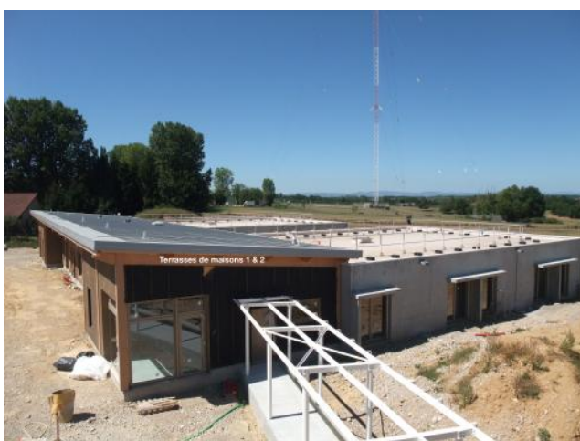
Façades Sud de M1 et M2
