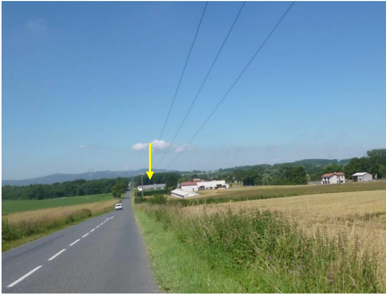
Vue sur la zone depuis la route des Echets (RD 38). La parcelle ZK 131 se situe à l'arrière du bâtiment de la carrosserie (fléché).
